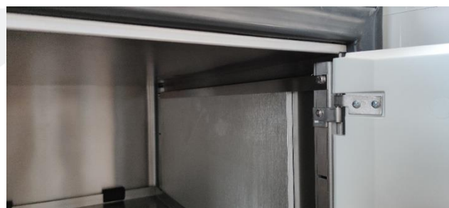
Photo 4 : Plaque cryo-accumulatrice placée sur le côté droit d'un congélateur, vue coin intérieur droit
