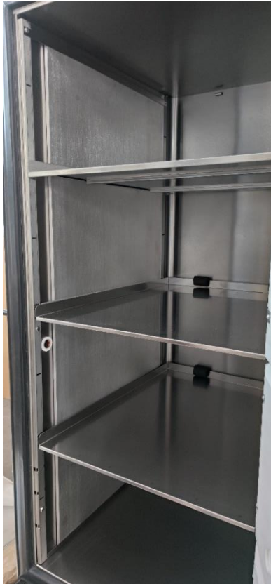
Photo 1 : Plaque cryo-accumulatrice placée sur le côté gauche d'un congélateur, vue entière intérieur gauche
